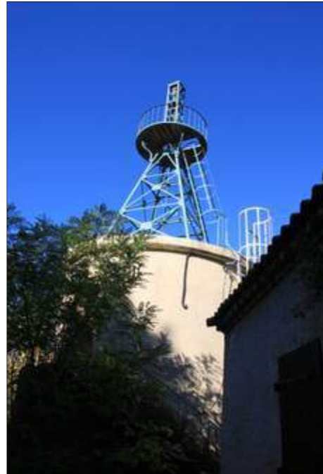
Le puits-éolienne de Bélarga
