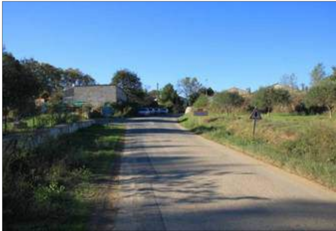
L'entrée Sud-Est le long de la route départementale 123
