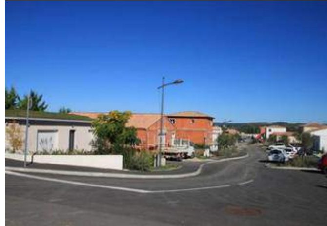
Espaces extérieurs – lotissement
