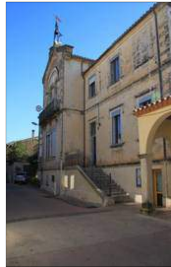
Le seuil des anciennes mairie et école en 2016, photo-reconstruction Source : L'Artifex
