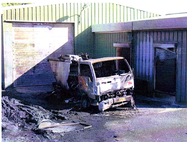
La bennette totalement détruite par le feu, les bâtiments endommagés
